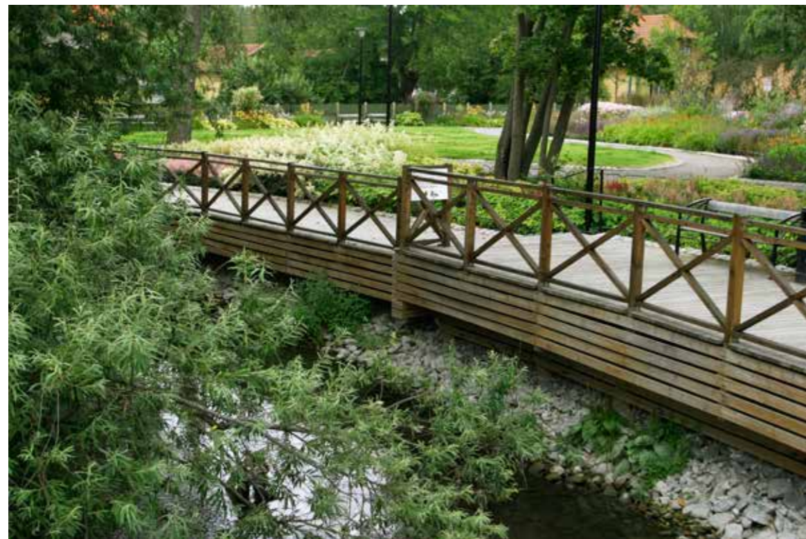
Järnvägsparken vid Upplands Väsby station
