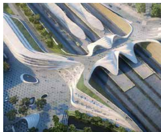
Ovan t.v. Exempel på utformning av norra bron över spårområdet. En öppen bro som skapar en överblick och kontakt mellan den östra och den västra sidan. Trapporna förbinder bron med torget och har placerats centralt i Centralvägens siktlinje. Tillsammans med en gång- och cykelramp (nederst i bild) och bussterminal med rulltrappor (till vänster i bild) skapas flera valmöjligheter för gångtrafikanter. Konstnärlig bearbetning av Zaha Hadid Architects.
