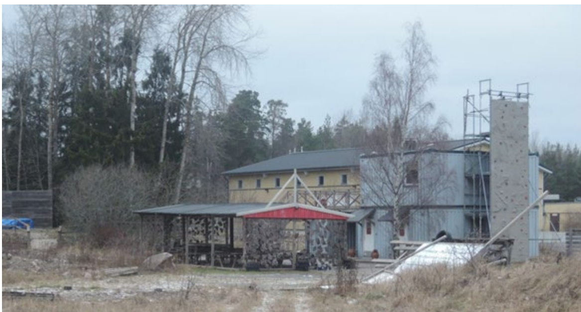
Paintball-verksamheten inom fastigheten Borgby 1:5.
