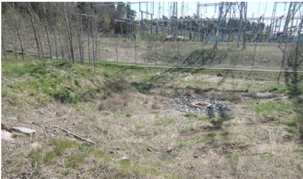
Utsläppet för de befintliga dagvattenledningarna i betong. Brunnen leder ner i ledning under mottagningsstationen.
