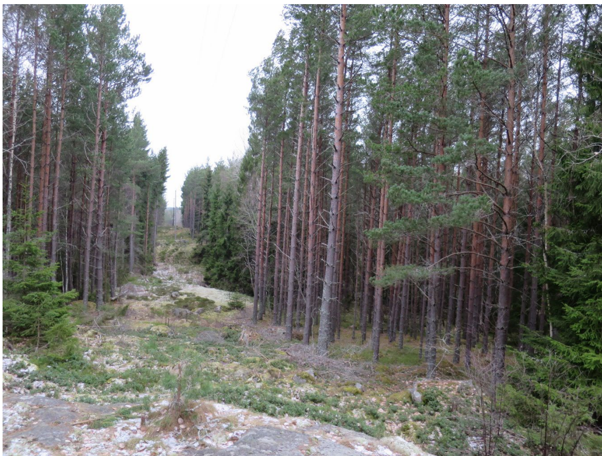
Luftledning diagonalt genom skogsområdet i norr.
