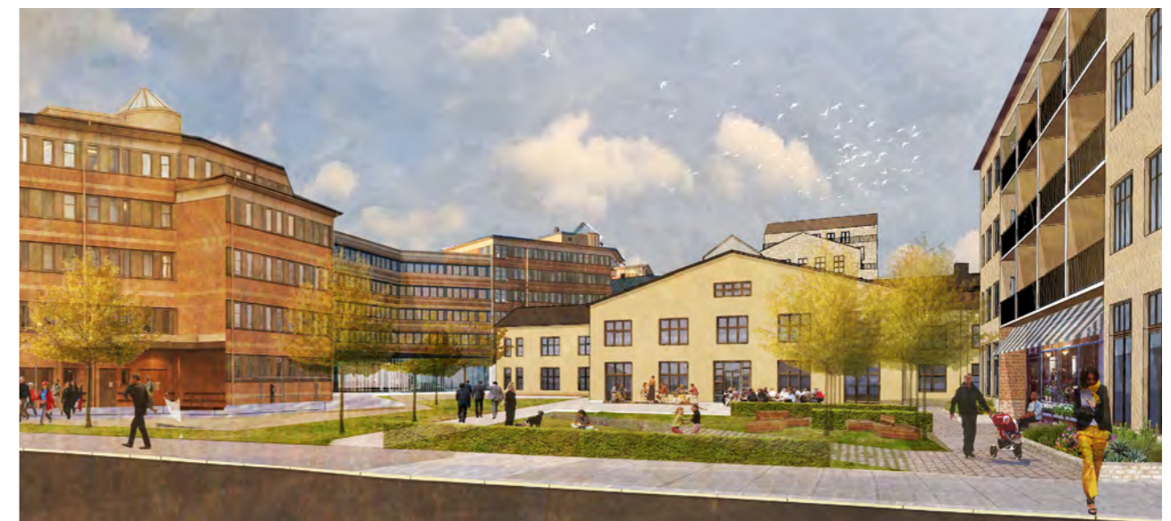
Vy från syd av länkbyggnaden mellan kontorshuset ATV 3 resp. ATV 1
