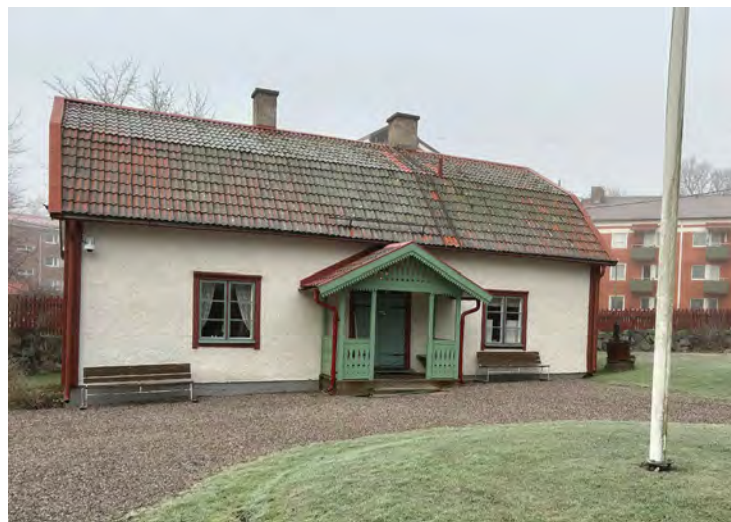
Hembygdsgården, Nedra Runby gård, med bevarad äldre karaktär.
