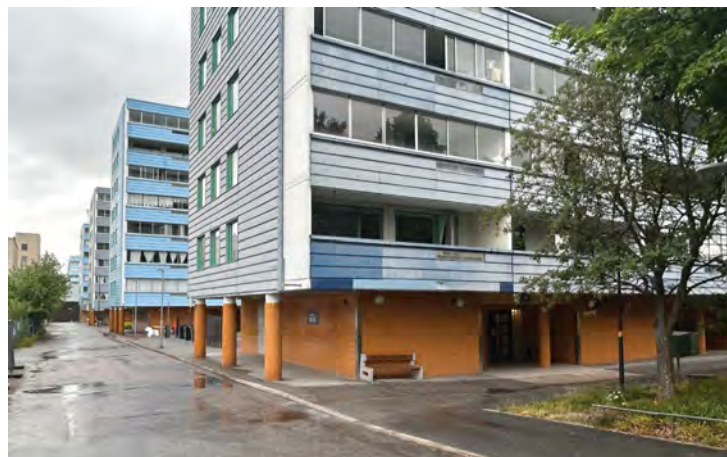
Skivhusen möter ett bilfritt gångstråk i väster. Sockelväning med gult glaserat kakel och kakelklädda pelargångar.
