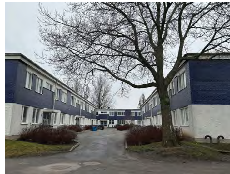
Entréerna ligger vända mot en gemensam entrésida.
