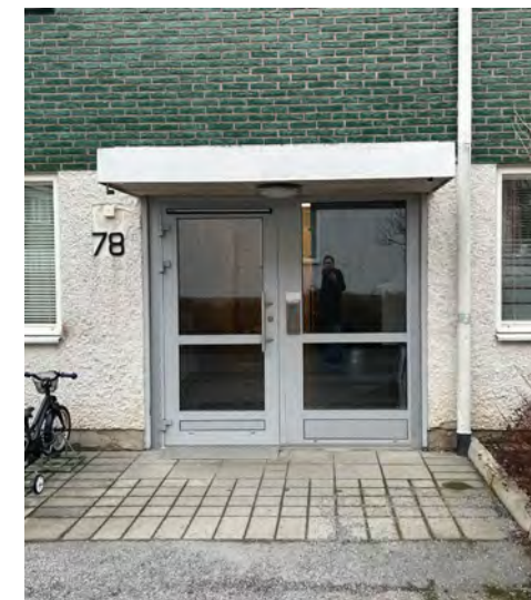
Entrédörr i aluminium och skärmtak i plåt.
