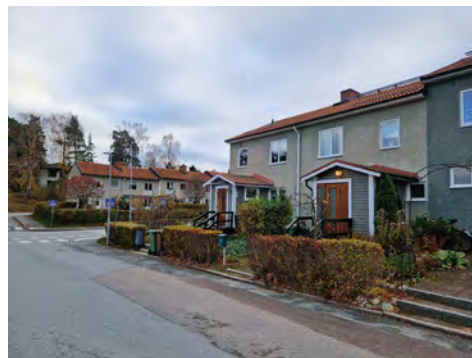
Tillbygda entréer mot Lagmansvägen.
