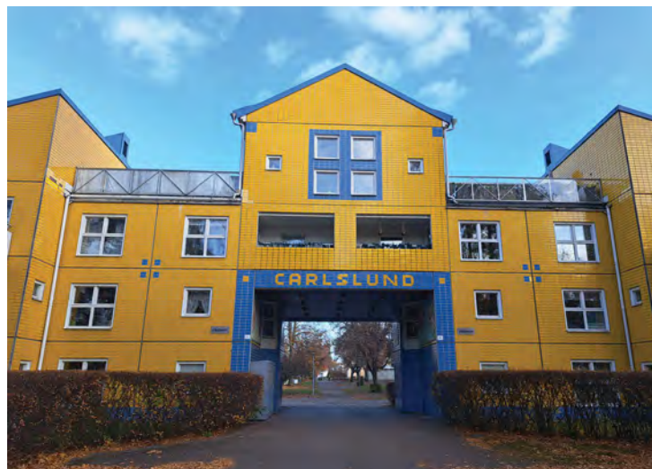
Den lekfullt utformade portalbyggnaden med gul och blå kakelfasad utgör ett landmärke för området.
