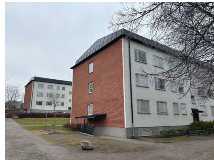
Fasad i tegel och ljus puts och flacka plåttäckta sadeltak med utkragning.
