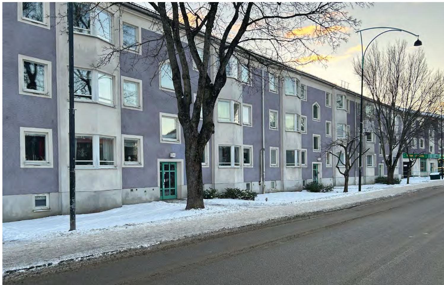
Kvarter mot Centralvägen med tidstypisk och väl utförd fasadarkitektur, tex burspråk, trapphus och fönsterplacering.
