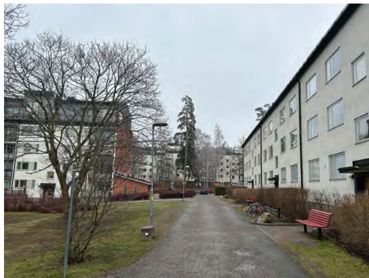
Kvarter med påbyggd våning intill en mer välbevarad byggnad i tre våningar.
