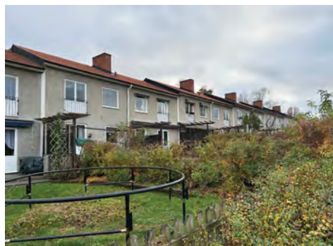
Enhetligt putsade fasader med vita band mellan husen längs Oxundavägen.
