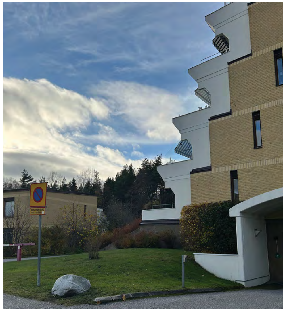
Terrasshusen på Lövstavägen har en karaktäristisk gavelsektion med utanpåliggande terrasser i målad betong. Under husen ligger garage med entré från gaveln mot gatan under en portik med välvt tak.
