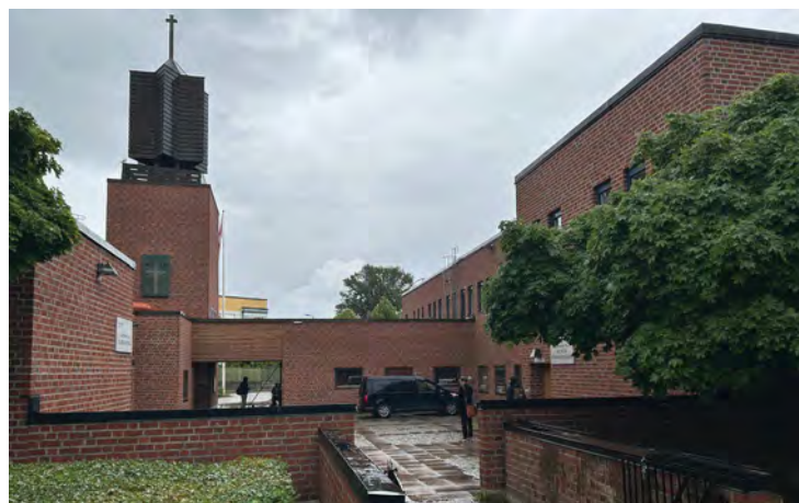
Vilunda kyrka, sammanbyggd med församlingshemmet, uppförd i rödbrunt tegel.
