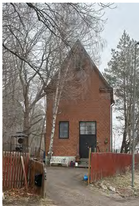
Ställverket med särpräglad högre volym och funktionsbetingad utformning med tegelfasad.
