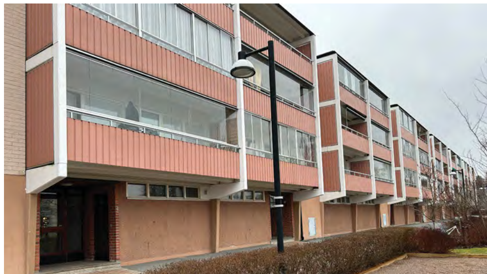
Utanpåliggande balkonger på betongkonsoler. Sluten sockelvåning med omsorgsfulla entréer mot gården.
