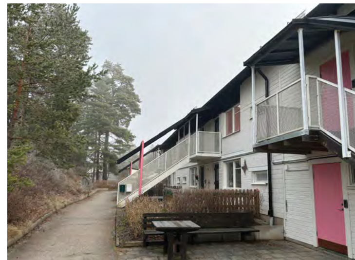
Bostadsentréer via trapplopp med tak mot bostadsgården.
