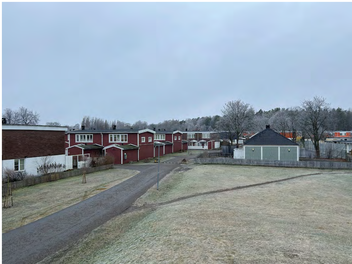
Den täta bebyggelsestrukturen kontrasterar de genomkorsande parkstråkens öppna ytor. I fonden syns Smedbyskogen som bildar rygg mot den enhetliga och låga bebyggelsen på dalbotten.
