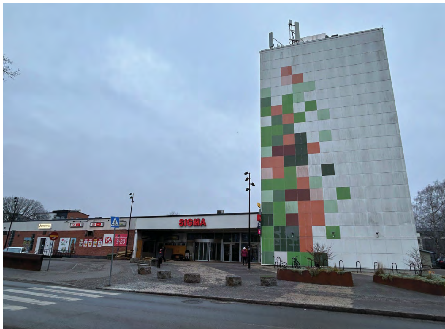
Sigma centrums fasad mot Hammarbyvägen. Skivhusets slutna fasad har getts en ny utformning med vita och färgade rutor, men var ursprungligen enfärgad och slät.
