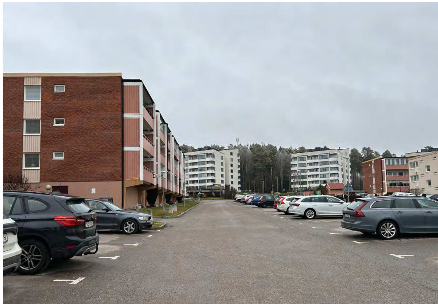
Skogen på Stockholmsåsen tecknar fond bakom punkthusen vid Holmvägen. I förgrunden kvarter med lamellhus. De sammanhållna taknivåerna och bebyggelsens gruppvisa enhetliga skala är karaktäristisk, liksom stora markparkeringar mot gatorna på kvarterens utsidor.
